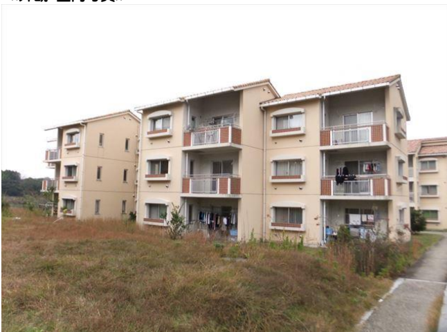
◀外観・室内写真▶
