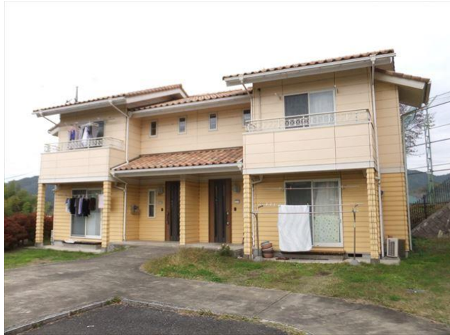
◀外観・室内写真▶
