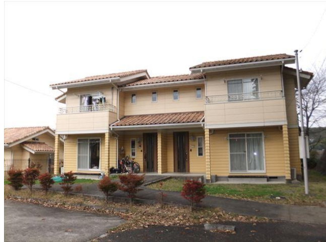
◀外観・室内写真▶
