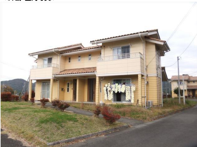
◀外観・室内写真▶
