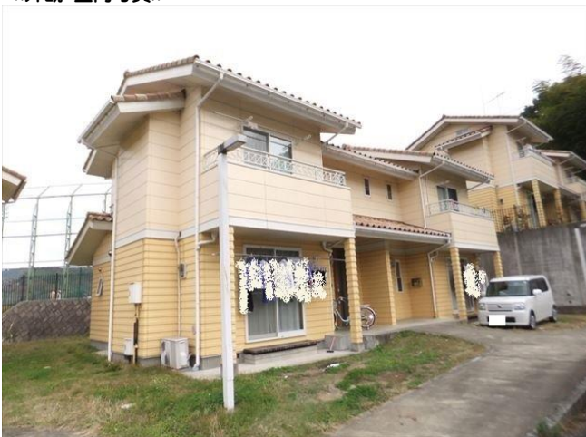
◀外観・室内写真▶
