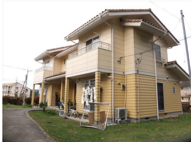
◀外観・室内写真▶
