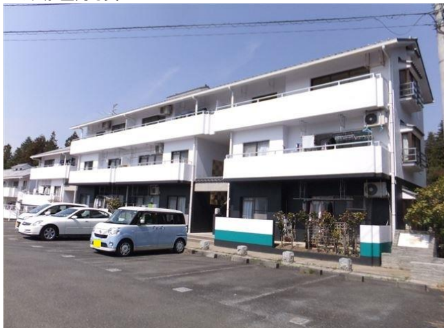
◀外観・室内写真▶
